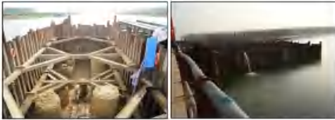
图 5.3.1-1 安徽怀洪新河桥梁桩基施工设置钢围堰周围保持水体清澈
