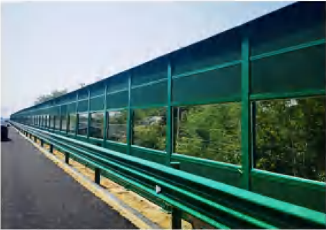
图 6.3.1-3 本项目拟采取的泡沫铝板折板式声屏障示意图
